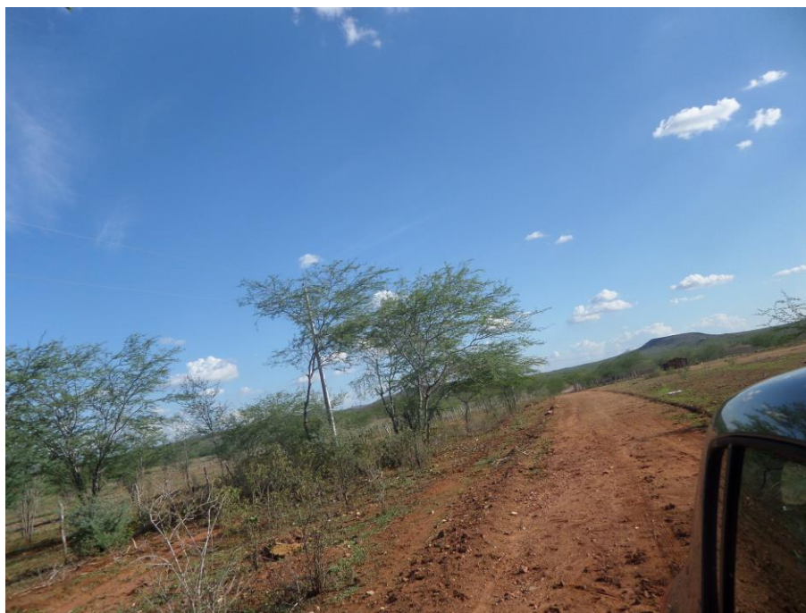
Figura 6.5 – Estrada vicinal sem manutenção adequada, sub-bacia do Rio Curituba, Assentamento Mandacaru, Canindé de São Francisco-SE
