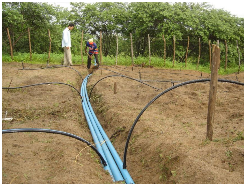
Figura 6.3 – Sistema Bubbler de irrigação de baixo custo
