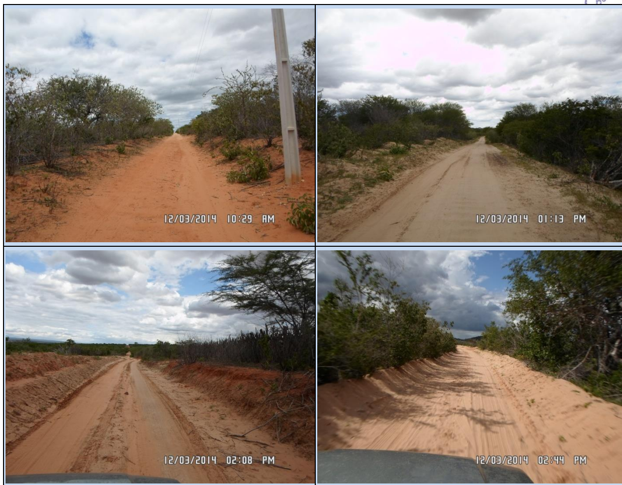
Figura 6.5 - Estradas rurais a serem adequadas.
