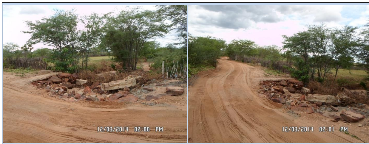
Figura 6.7 - Local onde deverá ser construída a passagem molhada.
