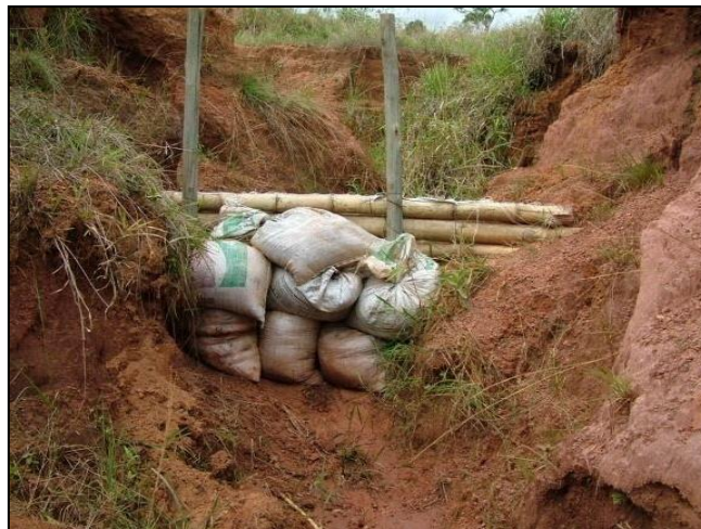
Figura 8 - Paliçada de bambu para contenção de processo erosivo.
