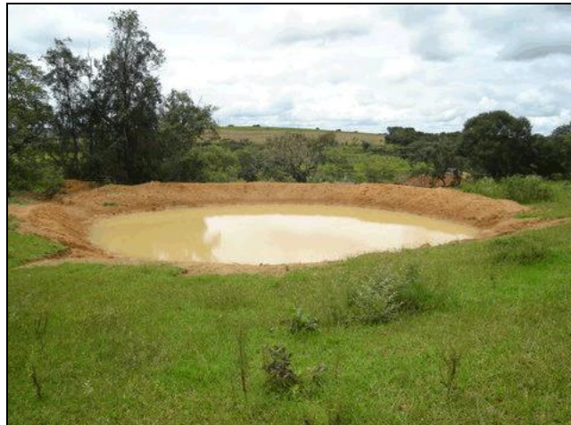
Figura 7 - Bacia de captação de águas de chuva (barraginha).
