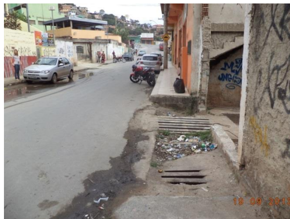
Figura 4.17 – Grelha de captação da galeria da Rua Montes Claros
