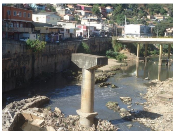
Figura 4.14 – Ribeirão Arrudas sob a Ponte da Rua Guaxupé
