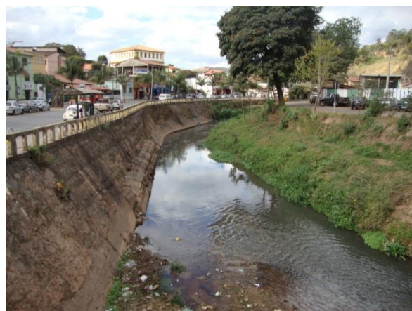
Figura 4.12 – Ribeirão Sabará – Avenida Perimetral, Sob a Ponte da Rua Mário Machado
