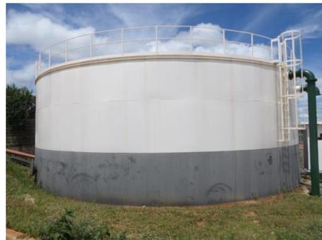
Figura 4.4 – RAP 2: metálico, 800 m<sup>3</sup>
