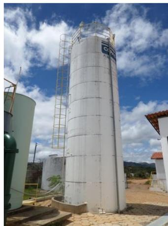
Figura 4.5 – RAP 3: metálico, 80 m<sup>3</sup>
