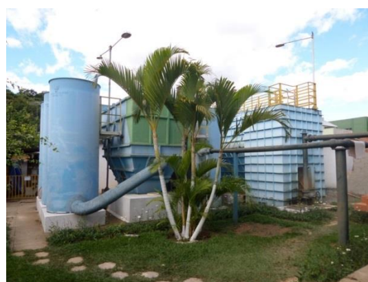
Figura 4-2 - Visão geral da ETA Jaboticatubas
