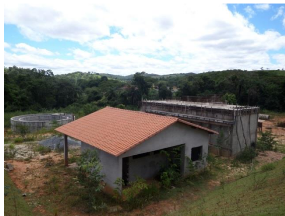
Figura 4-7 - Visão geral da ETE Jaboticatubas em obras
