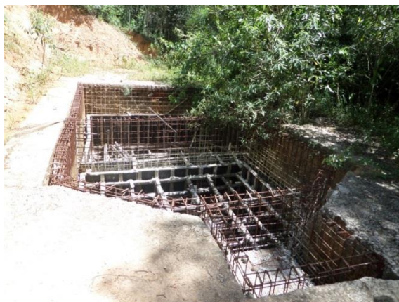
Figura 4-6 – Obras da Estação Elevatória de Esgoto
