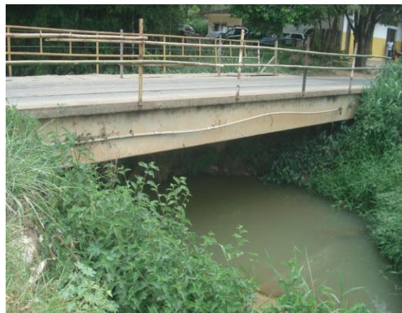
Figura 4-16 – Ponte sobre o Córrego da Paciência
