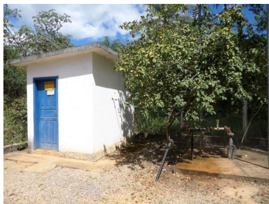
Figura 4-4 - Casa de química ao lado do poço C-01
