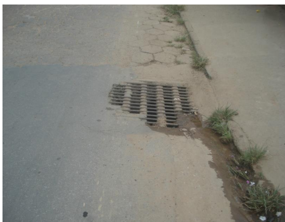
Figura 4-18 – Boca-de-lobo na sede municipal
