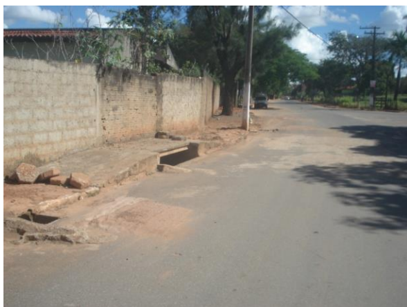
Figura 4.21 – Boca de lobo na Rua Evaristo Fernandes - Sede Fonte: COBRAPE (2014)
