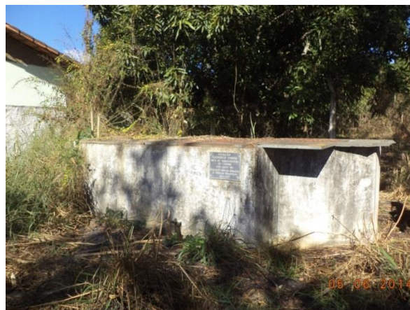
Figura 4.9 – Unidade para o tratamento preliminar do esgoto na ETE desativada de Núcleo João Pinheiro
