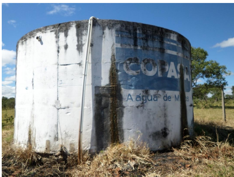
Figura 7.85 – Detalhe para a existência de vazamentos no reservatório 01 do sistema Núcleo João Pinheiro
