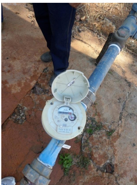
Figura 7.77 – Detalhe para o macromedidor do poço artesiano E-02 de Núcleo João Pinheiro
