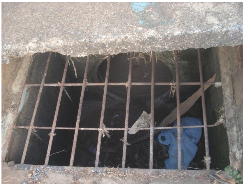
Figura 7.207 – Boca de lobo com grelha localizado na Rua Francisco CorrêaSobrinho - Sede
