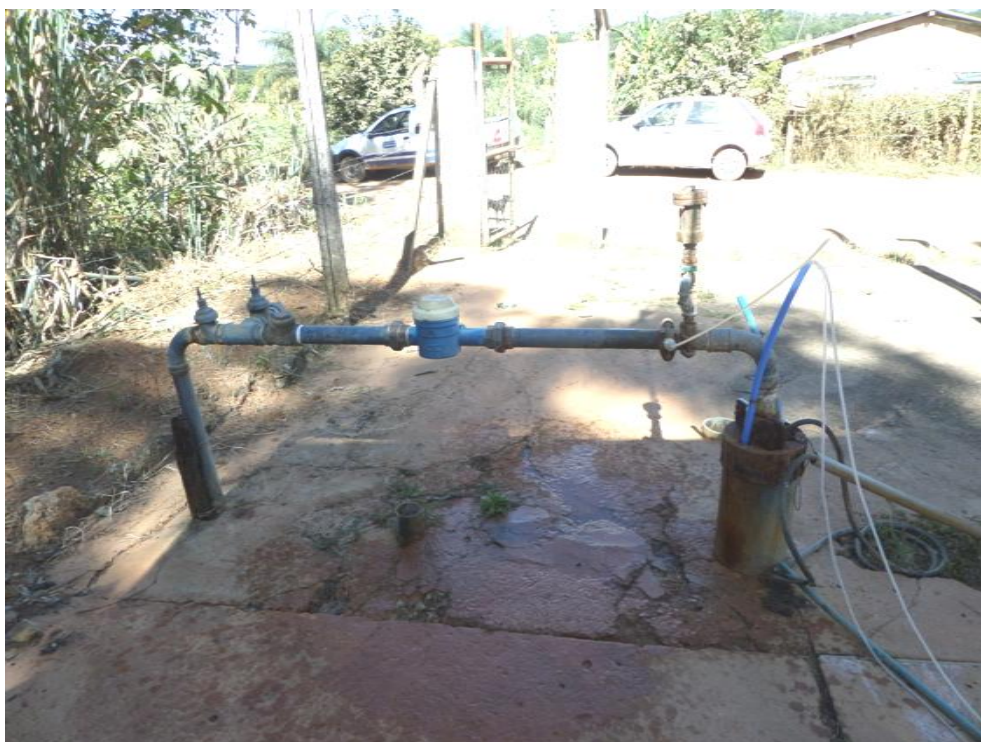
Figura 7.81– Tratamento da água no interior do poço E-02 do sistema Núcleo João Pinheiro. Detalhe para a exposição das mangueiras onde são conduzidos os produtos químicos
