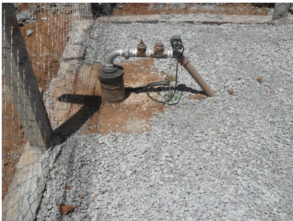
Figura 7.95 – Detalhe do poço artesiano de Tronqueiras
