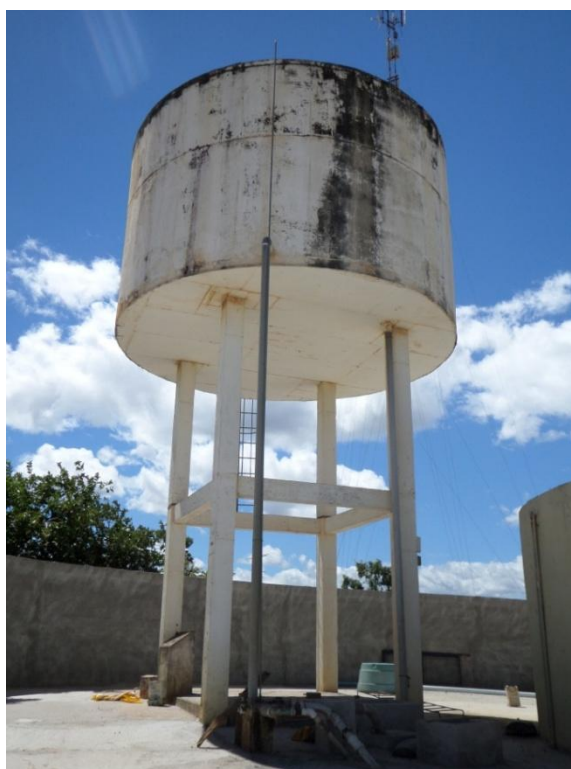
Figura 7.65 – Detalhe para a existência de vazamentos no reservatório 01 (bairro Novo Brasil)
