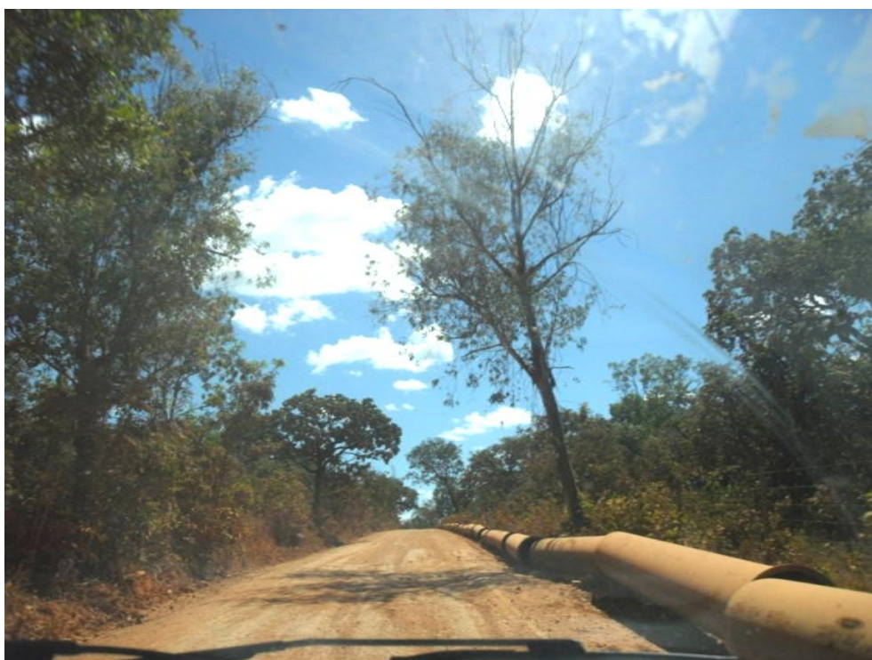
Figura 7.51 – Posicionamento das manilhas para adução da água
