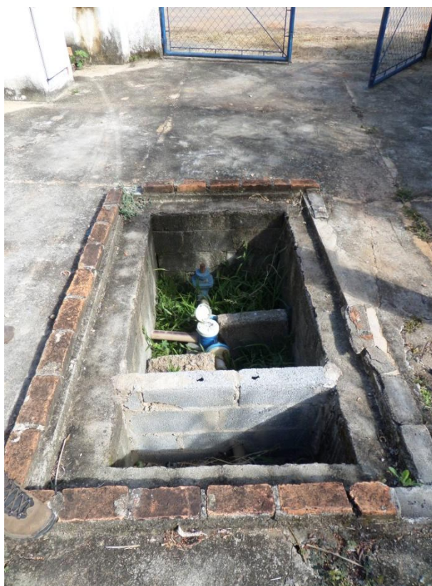
Figura 7.74– Detalhe para o macromedidor do poço artesiano E-01 no Núcleo João Pinheiro
