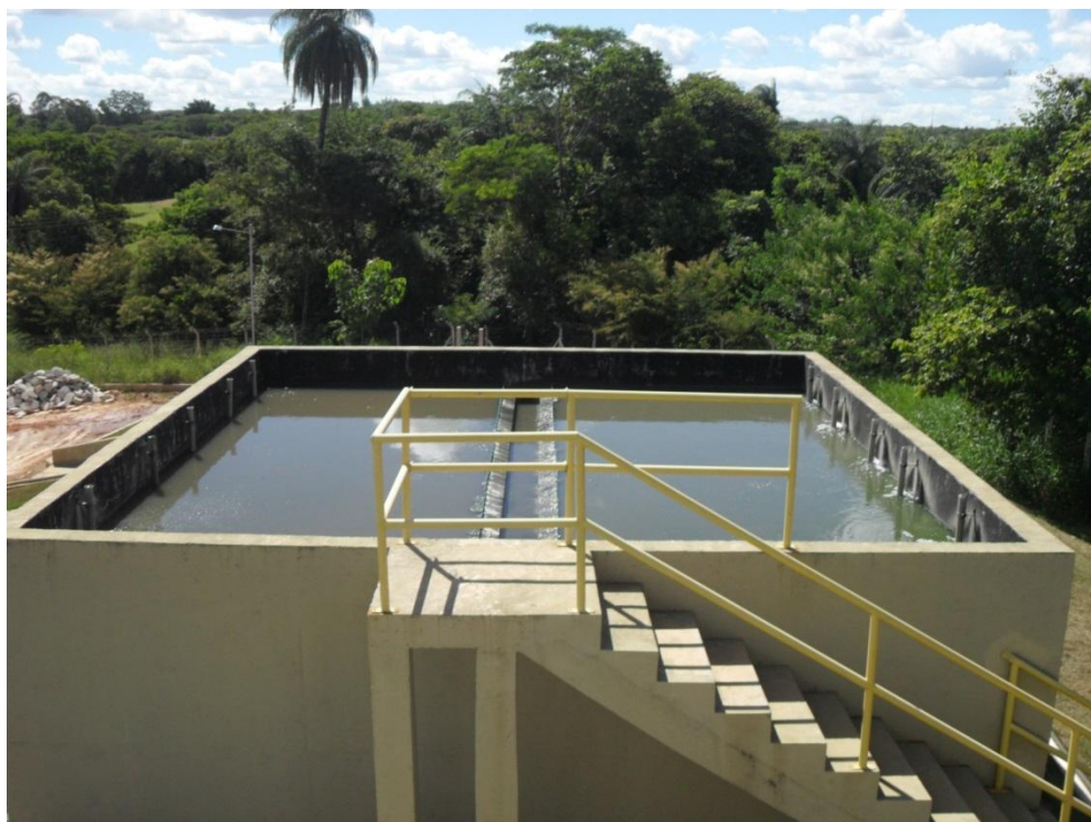
Figura 7.120 – Filtro anaeróbio de fluxo ascendente da ETE Funilândia
