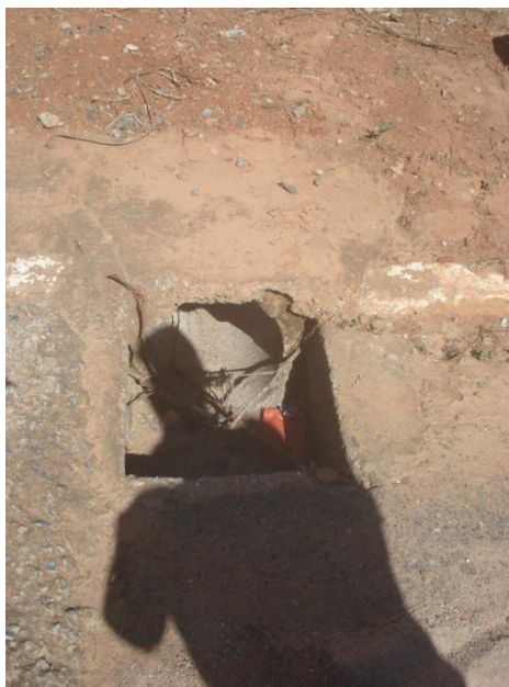
Detalhe de uma caixa de captação de águas pluviais sem grelha - Rua Evaristo Fernandes
