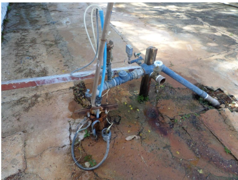
Figura 7.78 – Mangueiras para a condução do cloro e do flúor até o interior do poço E-01 do sistema Núcleo João Pinheiro
