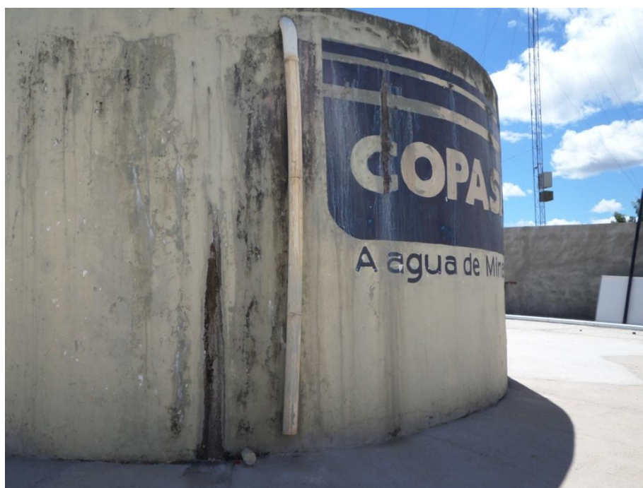
Figura 7.66 – Detalhe para os desgastes da estrutura do reservatório 02 (bairro Novo Brasil)
