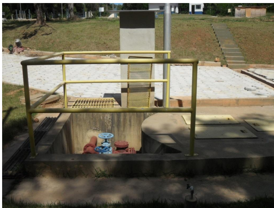
Figura 7.118 – Estação elevatória do efluente do tratamento preliminar para o reator UASB
