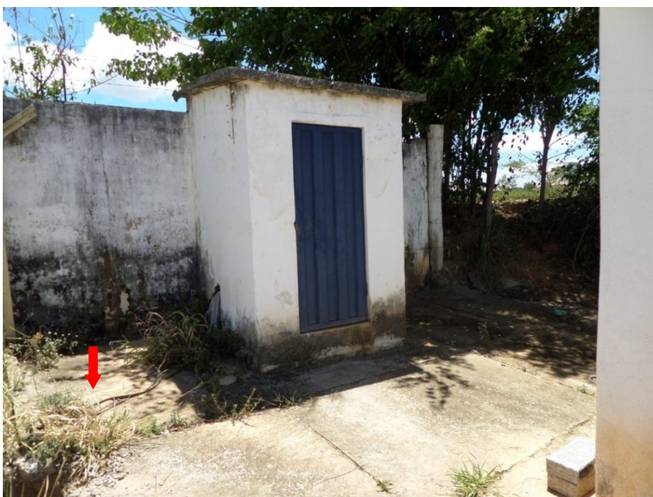
Figura 7.59 – Casa de química utilizada pelo poço C-04. Detalhe para a exposição das mangueiras onde são conduzidos os produtos químicos
