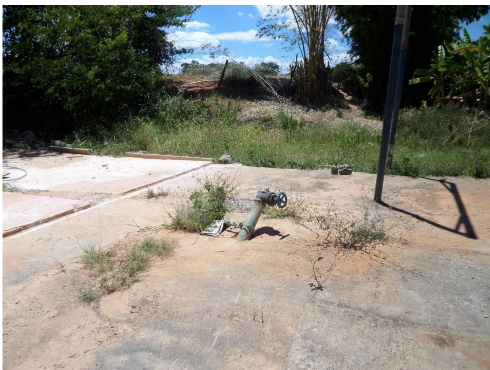
Figura 7.56 – Detalhe para a desativação do poço E-02
