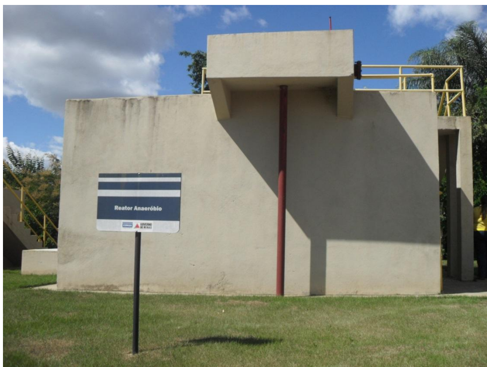
Figura 7.119 – Reator UASB da ETE Funilândia
