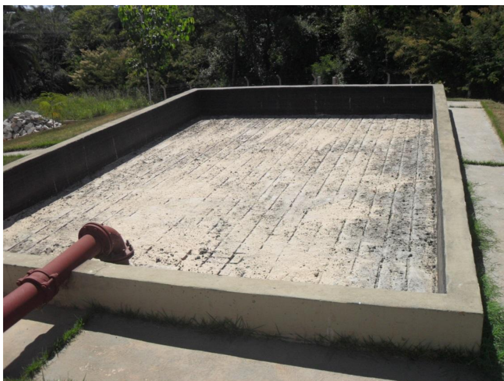
Figura 7.121 – Leito de secagem do lodo da ETE Funilândia
