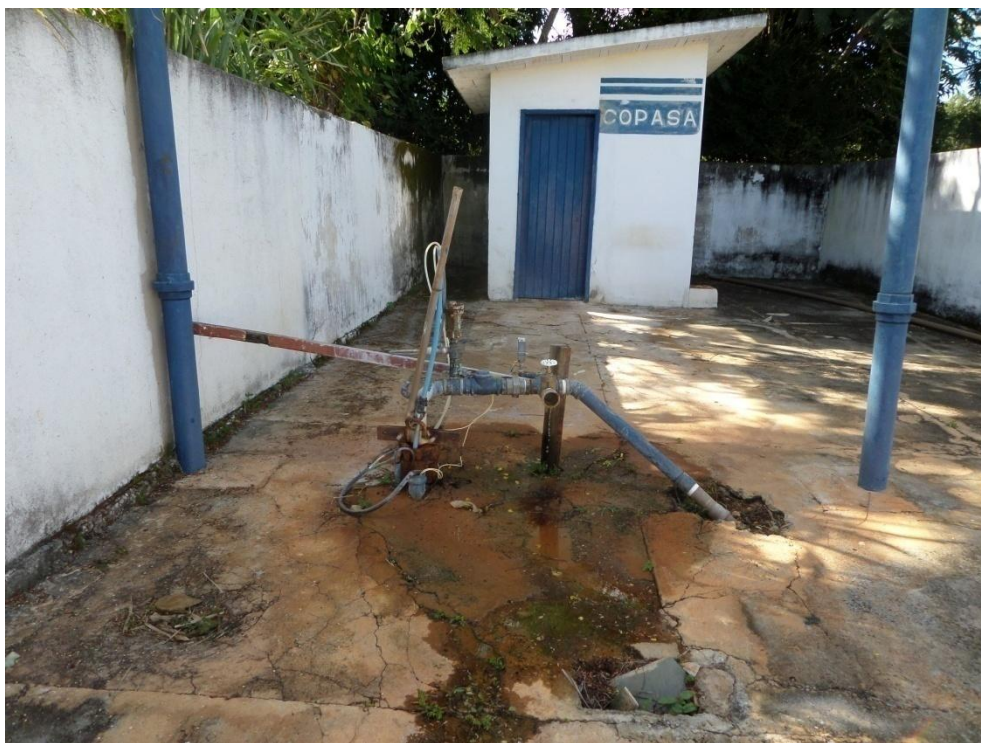
Figura 7.73 – Detalhe para o vazamento no poço E-01 no Núcleo João Pinheiro
