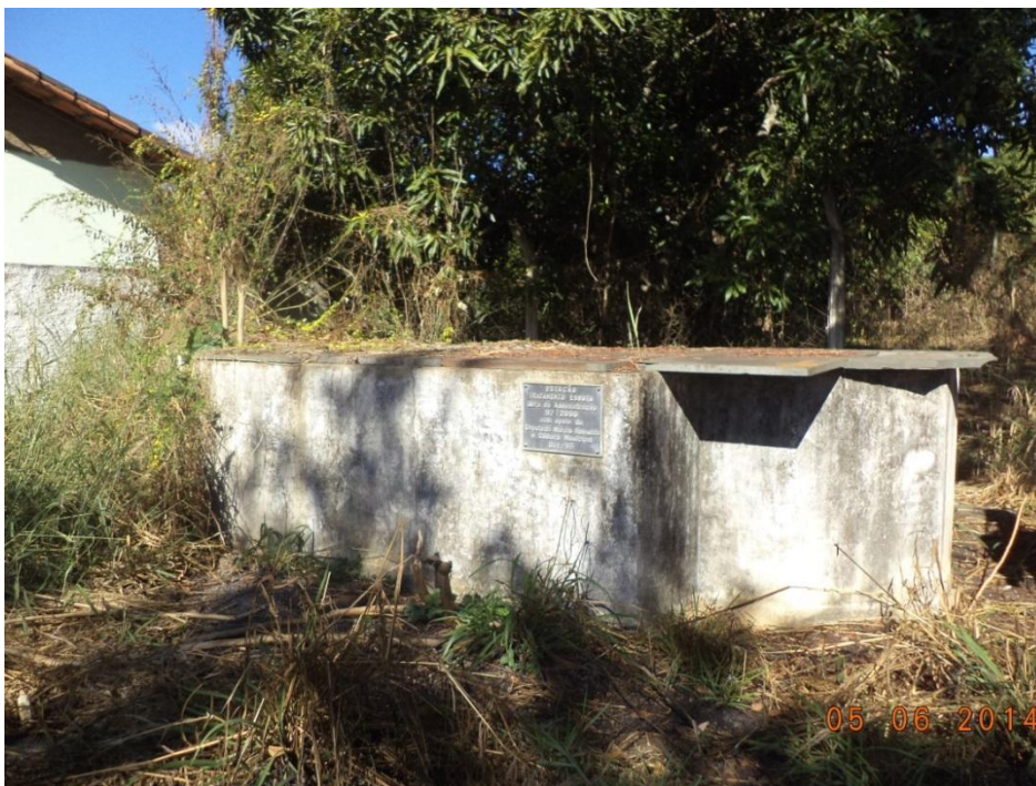
Figura 7.125 – Unidade para o tratamento preliminar do esgoto na ETE desativada de Núcleo João Pinheiro
