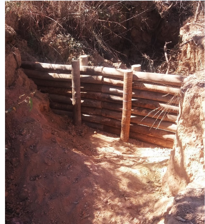
Paliçadas executadas em voçoroca Fonte: Inovesa (2018)
