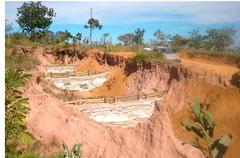
Paliçadas executadas em voçoroca Fonte: Inovesa (2017)
