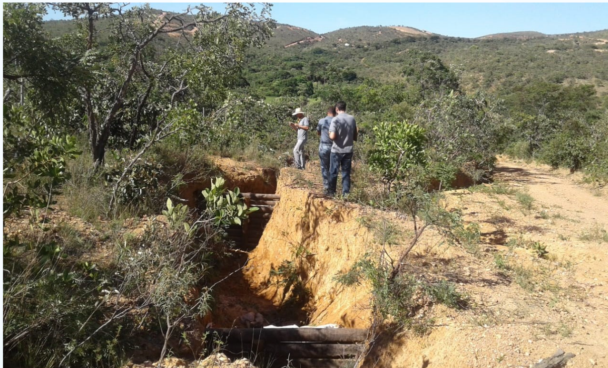
Paliçadas executadas em Jaboticatubas
