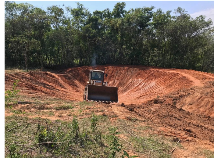
Execução de barraginhas Fonte: Inovesa (2018)
