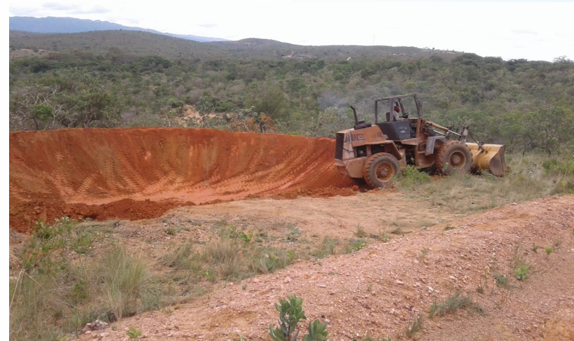
Barragem tipo 1 na UTE Rio Cipó Fonte: Inovesa (2019)
