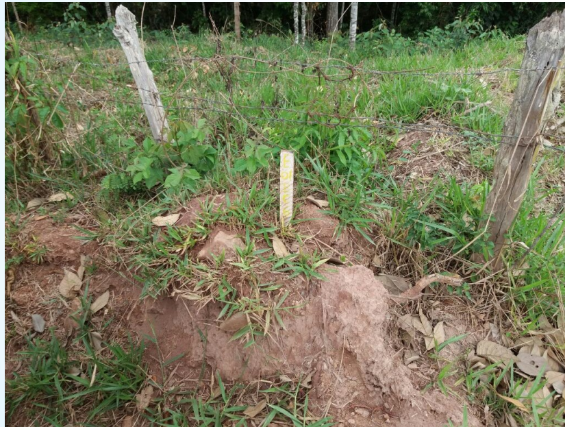
Levantamento e marcação topográfica
