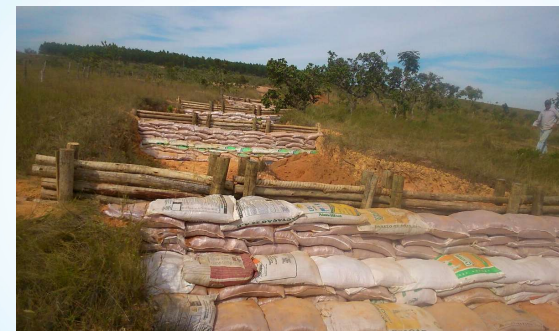
Paliçadas executadas em voçoroca
