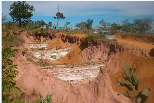
Paliçadas executadas em voçoroca
