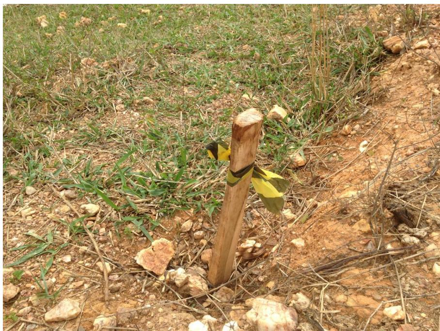
**Figura 7.1 – Locação e estaqueamento das bacias de contenção**
