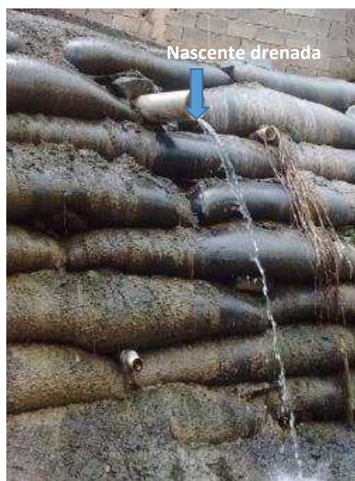
Figura 182 – Exemplo de nascente com presença de esgoto na Região da Sub-bacia do Ribeirão Isidoro – Nascente NAS312
