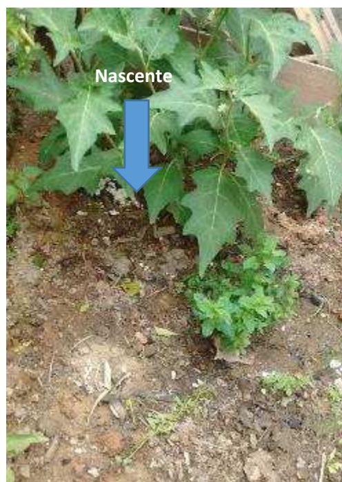
Figura 295 – Exemplo de nascente aterrada na Região da Sub-bacia do Baixo Onça – Nascente NAS107
