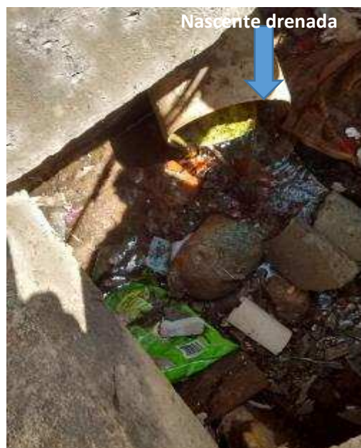
Figura 179 – Exemplo de nascente com presença de resíduos no entorno na Região da Sub-bacia do Ribeirão Isidoro – Nascente NAS160
