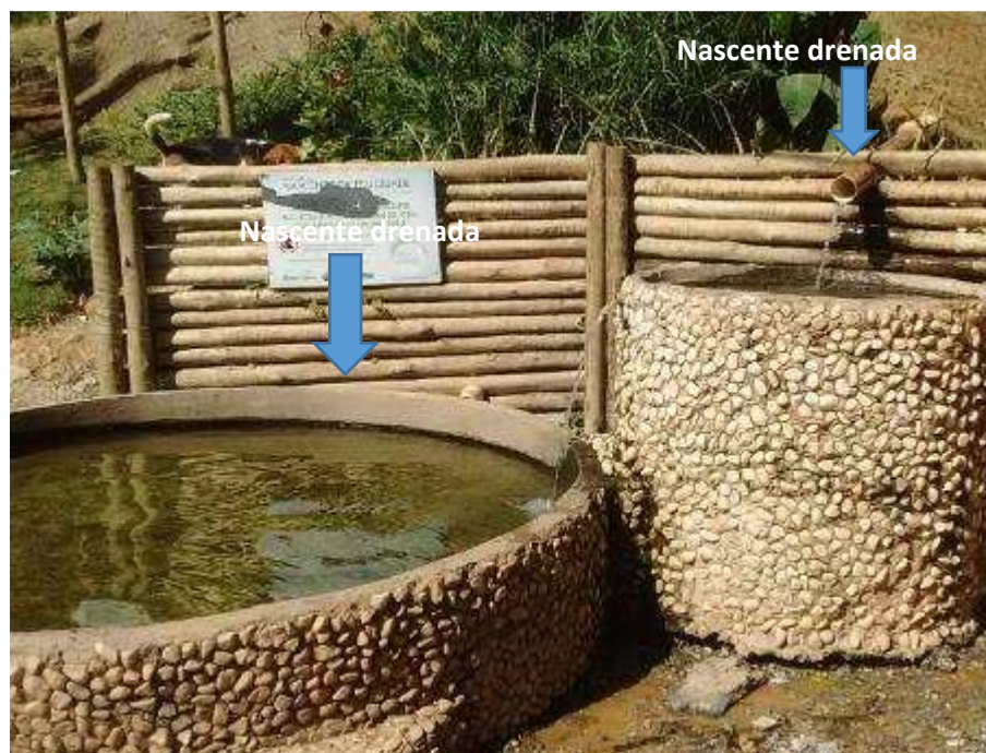
Figura 115 – Exemplo de nascente protegida na Região da Sub-bacia do Ribeirão Isidoro – Nascente NAS151
