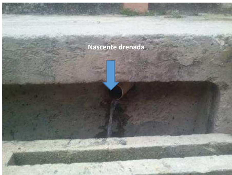
Figura 38 – Exemplo de nascente com vazão grande na Região da Sub-bacia do Córrego Vilarinho – Nascente NAS031
