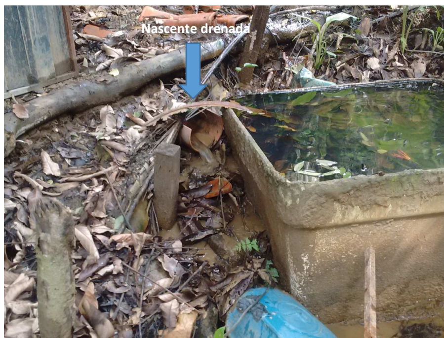
Figura 240 – Exemplo de nascente com geomorfologia associada a cavidade na qual foi instalado um cano na Região da Sub-bacia do Baixo Onça – Nascente NAS705
