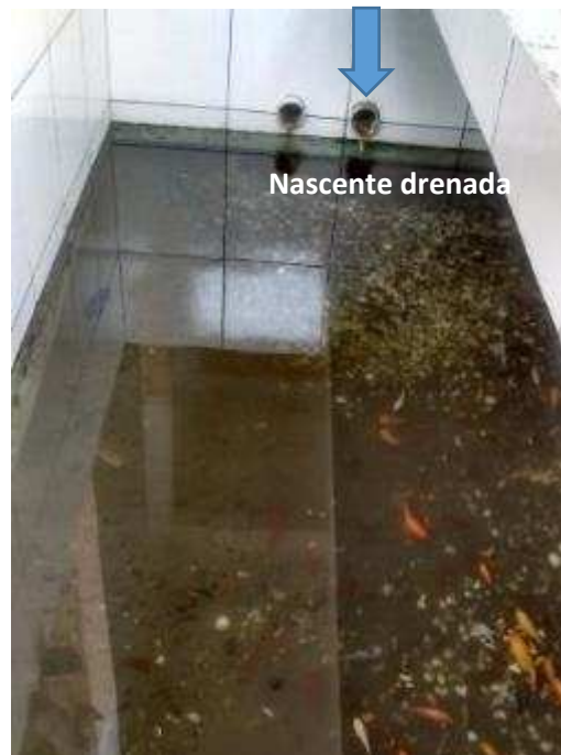
Figura 292 – Exemplo de nascente drenada confinada na Região da Sub-bacia do Baixo Onça – Nascente NAS297
