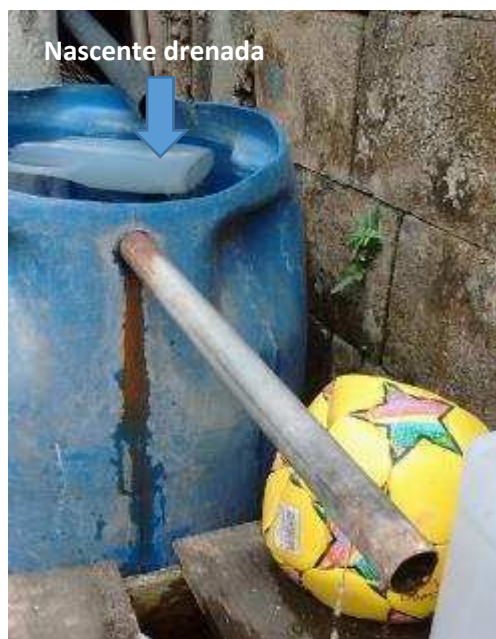
Figura 172 – Exemplo de nascente antropogênica na Região da Sub-bacia do Ribeirão Isidoro – Nascente NAS189
