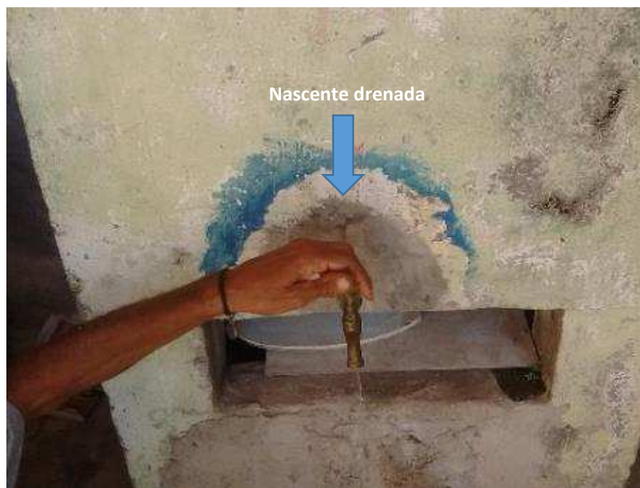
Figura 241 – Exemplo de nascente com geomorfologia indefinida na Região da Sub-bacia do Baixo Onça – Nascente NAS224
