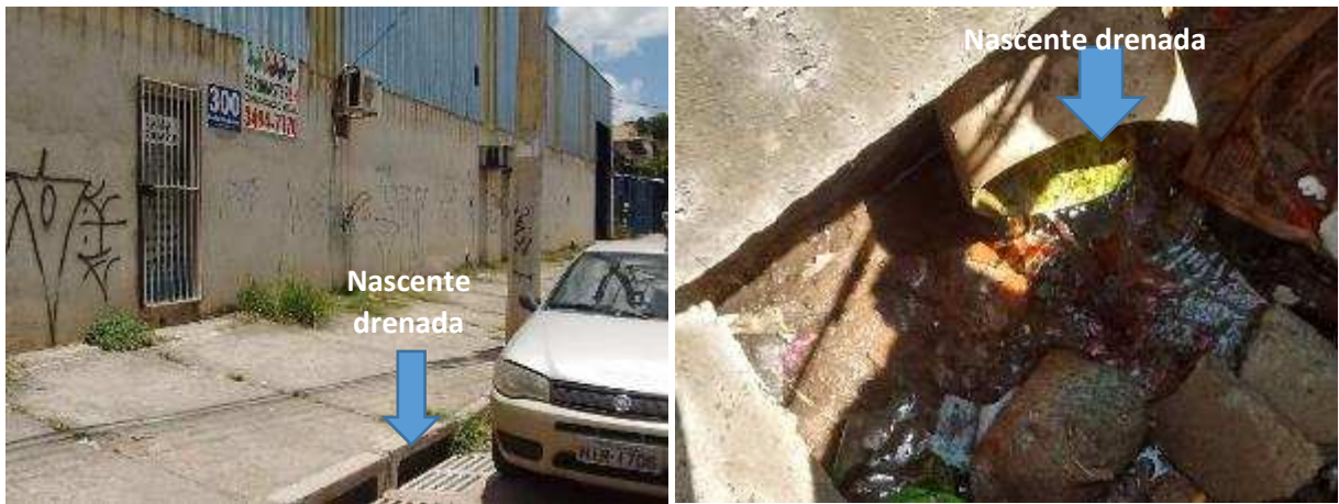
Figura 186 – Exemplo de nascente em área com alto grau de impermeabilização na Região da Sub-bacia do Ribeirão Isidoro – Nascente NAS427
