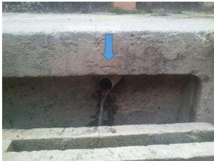
Figura 96 – Exemplo de nascente drenada na Região da Sub-bacia do Córrego Vilarinho – Nascente NAS031
