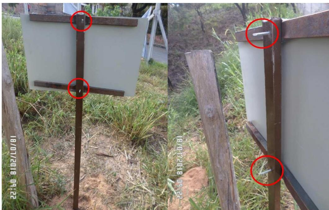
**Figura 29 – Placa Informativa 01 na área de plantio da Nascente Fundamental do Parque Ciliar do Ribeirão Onça, com destaque para os parafusos à vista, que representavam risco de acidente**
