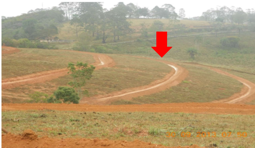
Construção de Terraço
