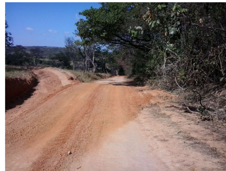
Construção de lombada
