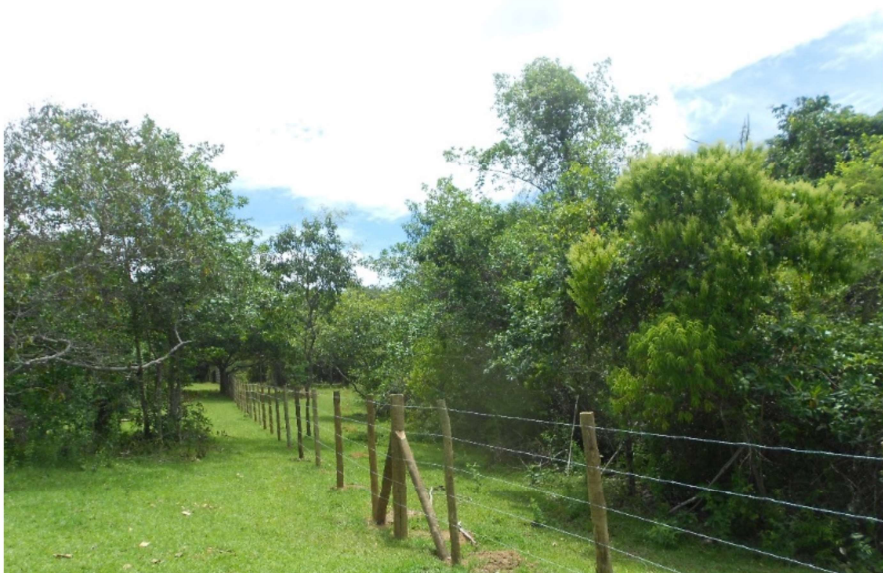
Construção de cerca
