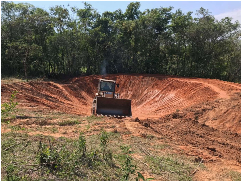
Construção de bacias de contenção tipo 1
