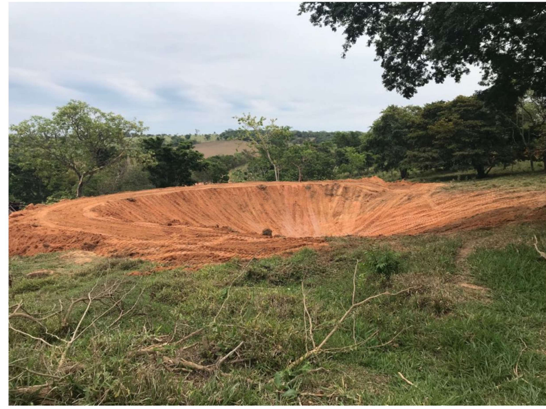
Bacia de contenção tipo 1
