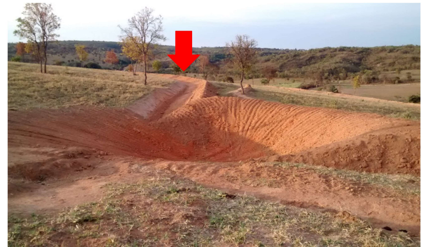
Terraceamento / Bacia de contenção
