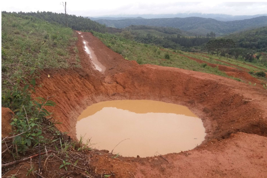
Bacias de contenção tipo 2
