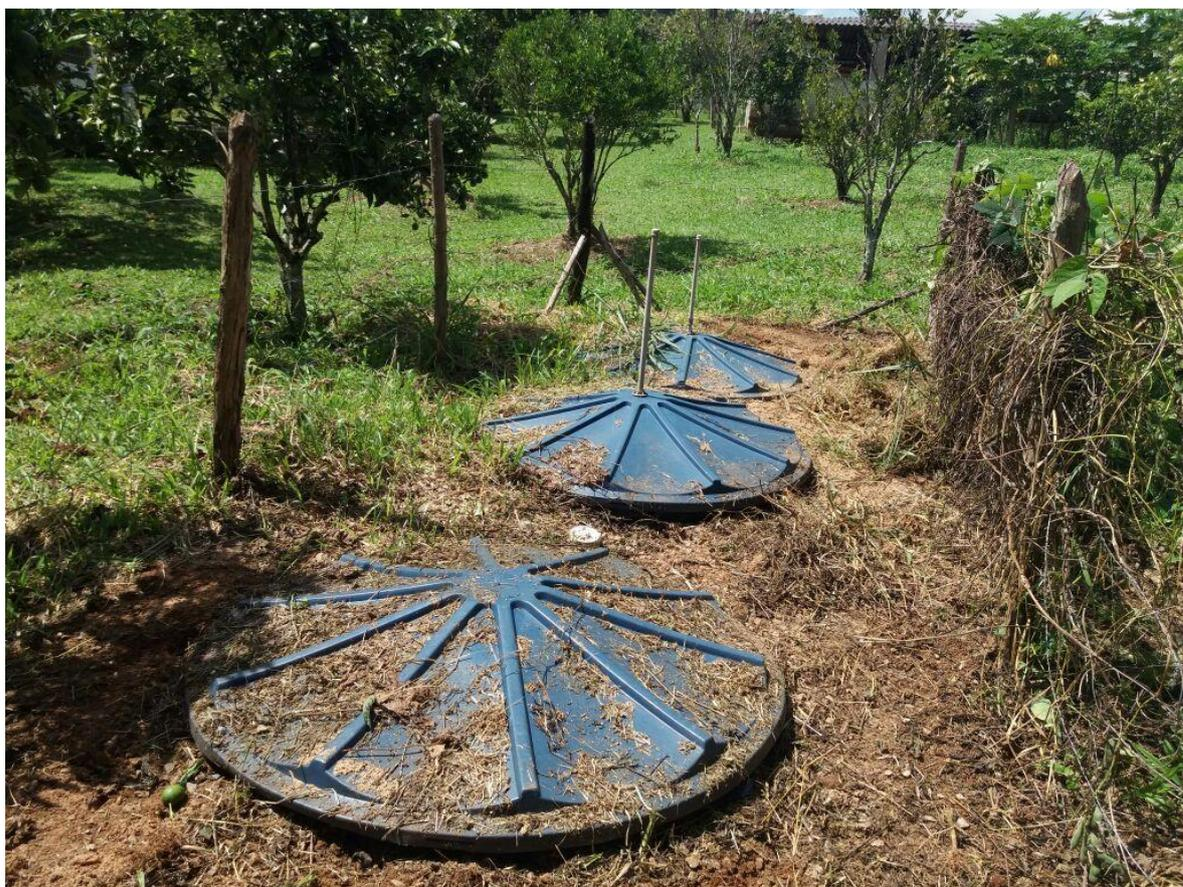
**Figura 14 - Fossa séptica biodigestora na Fazenda Conta-História**
