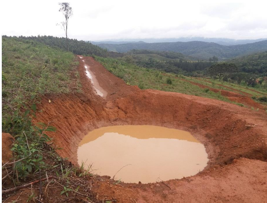
Figura 7 – Foto ilustrativa de uma bacia de contenção associada aos terraços.
