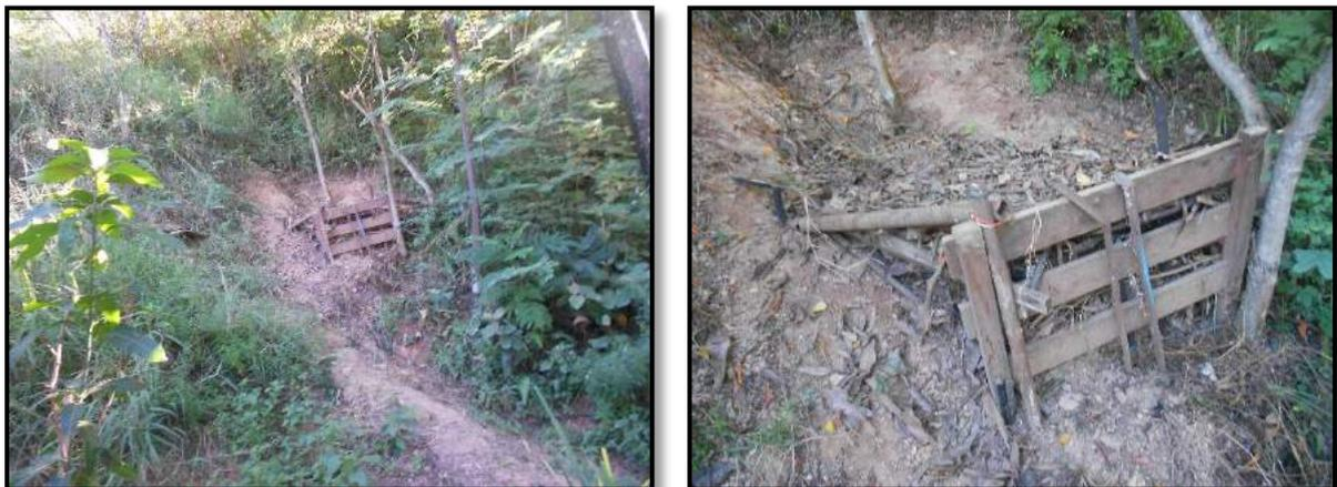
**Figura 54 - Local com incidência de erosão devido ao carreamento de sedimentos pela enxurrada.**
