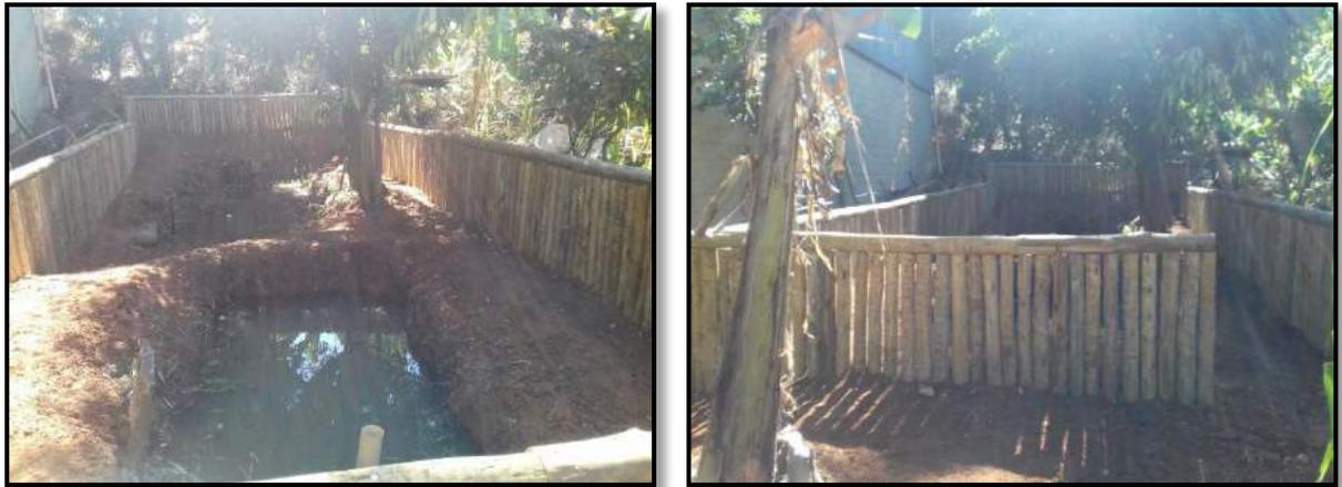
**Figura 68 - Cerca de mourão de eucalipto instalado para proteção dos aquários.**
