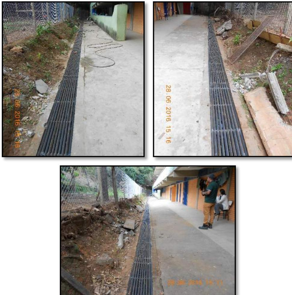
**Figura 65 - Canaletas após limpeza e instalação das grades de proteção.**
