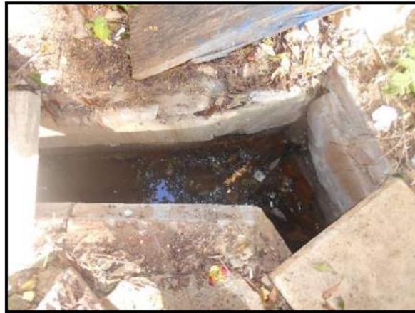
**Figura 64 - Canaletas com entulhos e sem a grade de proteção.**
