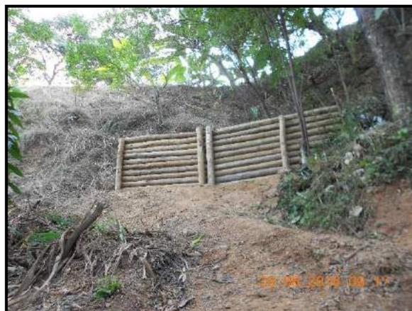
**Figura 56 - Paliçadas instaladas.**
