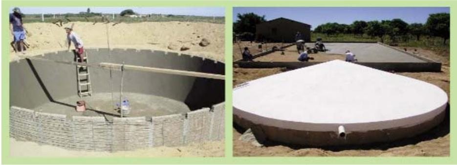
Figura 7. Construção de cisterna do Programa Água para Todos
